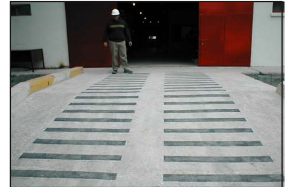
Rampa con franjas anti-deslizantes.
