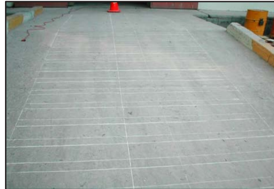
Preparación de superficie.
